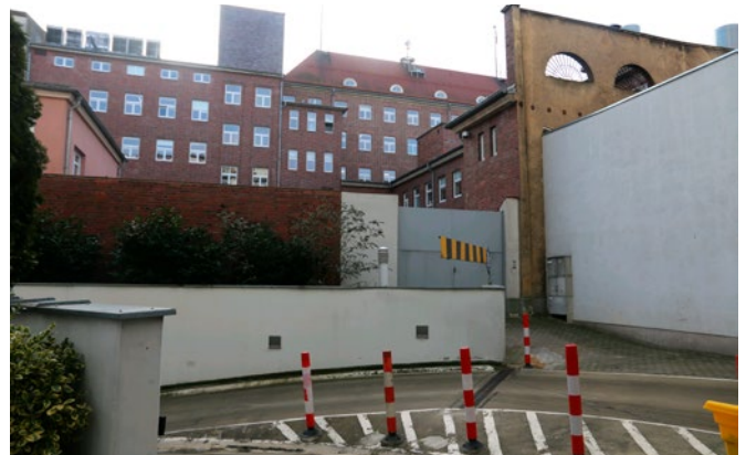
Fot. 3. Górna część wyjazdu z parkingu
