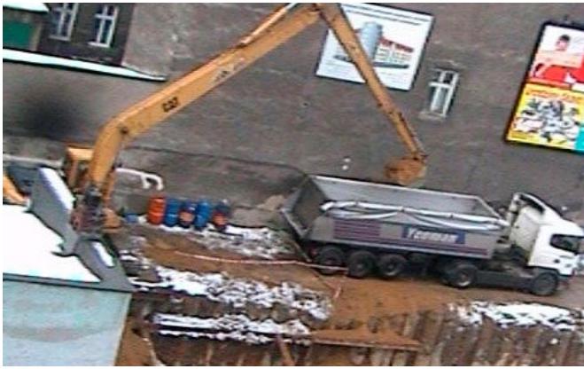
Fot. 1. Widok załadunku samochodu ziemią na samochód i wywóz na wysypisko
