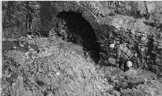
Część opisywanego muru, w którym można dostrzec obecnie trzy takie fragmenty.
