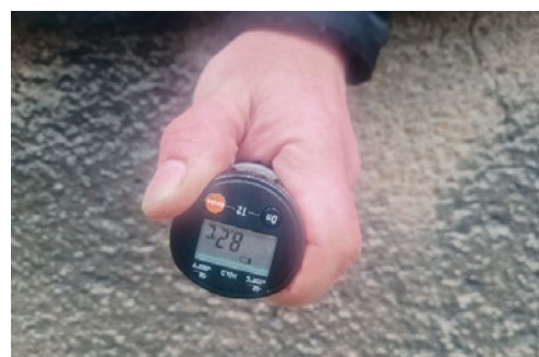
Fot. 8. Widok jednego z pomiarów wykorzystanego termometru do pomiarów temperatury powierzchni TESTO model T2 w trakcie pomiaru temperatury przegrody zewnętrznej jednego ze wskazanych mieszkań
