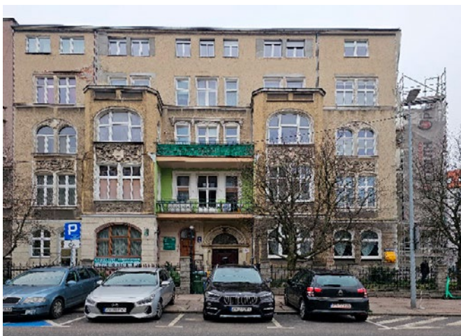
Fot. 1A. Ogólny widok części kamienicy z wejściem głównym od strony ul. Monte Cassino
