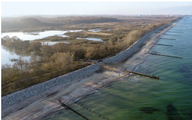
Fot. 14. Gotowe zabezpieczenie w Ekoparku Wschodnim w Kołobrzegu – opaska + sztuczne zasilanie
