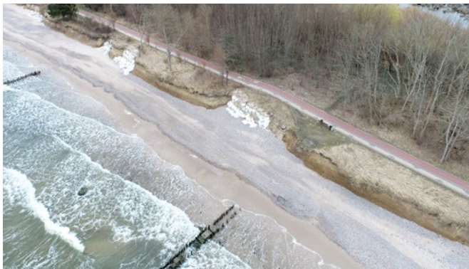
Fot. 9. Odcinki uszkodzonej grobli w Ekoparku Wschodnim w Kołobrzegu
