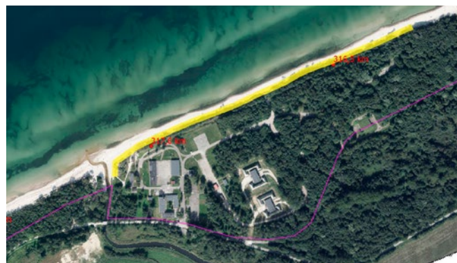
Fot. 5. Obszar prac w m. Pleśna
