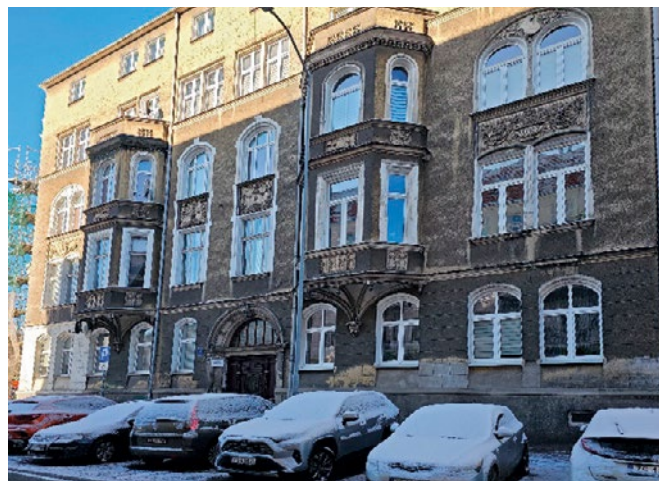
Fot. 1B. Ogólny widok części kamienicy z wejściem od strony ul. Mazurskiej
