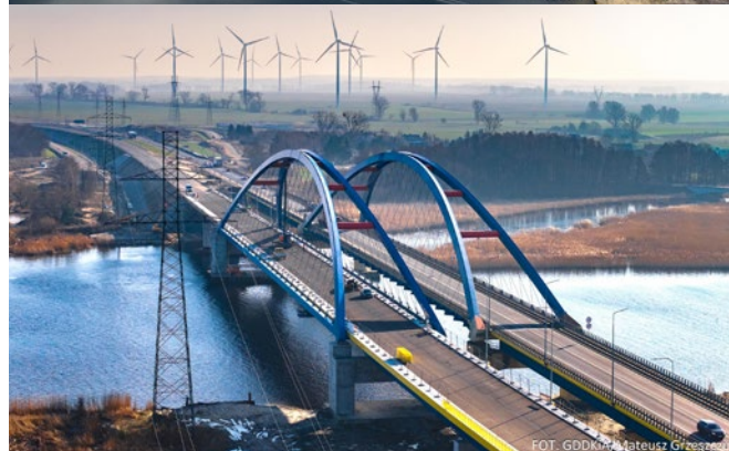
Most w Wolinie w ramach drogi S3
