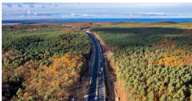
Droga S3 na odcinku Międzyzdroje–Dargobądz
