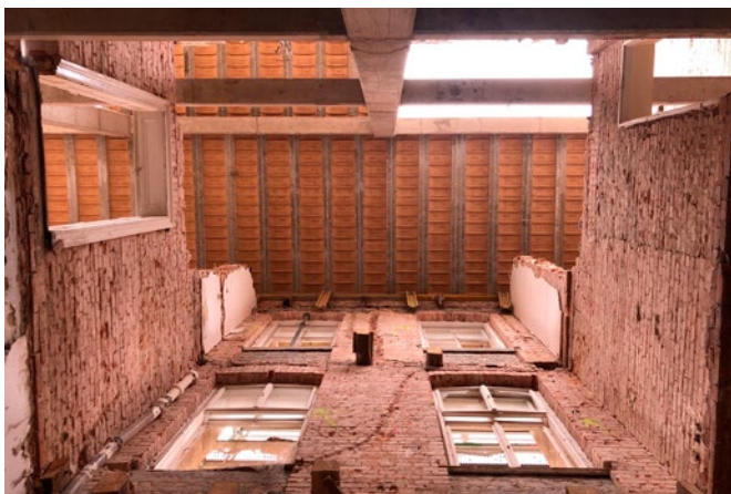
Montaż bez podpór montażowych
