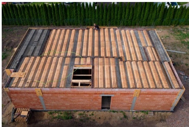
Strop z zastosowaniem różnych wypełnień
