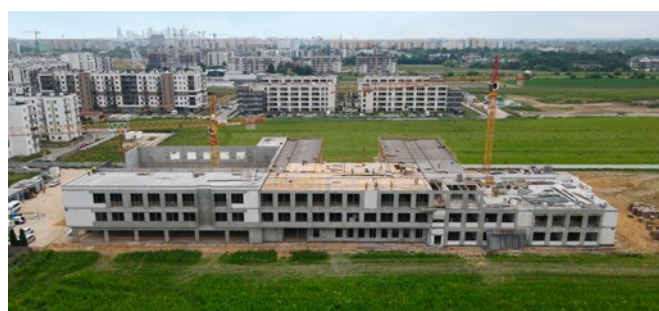
Budowa szkoły przy ul. Szeligowskiej w Warszawie
