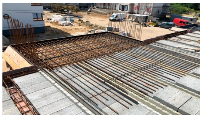
Montaż stropów na budynku hotelowym w Sarbinowie
