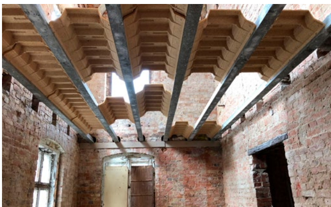
Montaż belek w gniazdach
