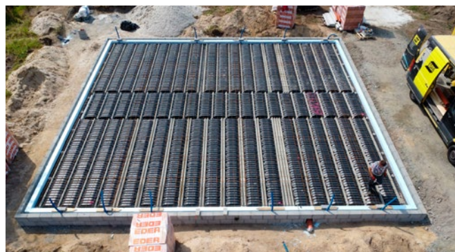
Strop RECTOPLAST – montaż nad przestrzenią wentylowaną
