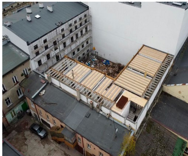
Rozbudowa kamienicy przy ul. Nawrot 50
