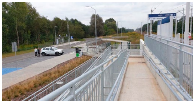
Przystanek osobowy Szczecin Dunikowo – widok przejścia podziemnego
