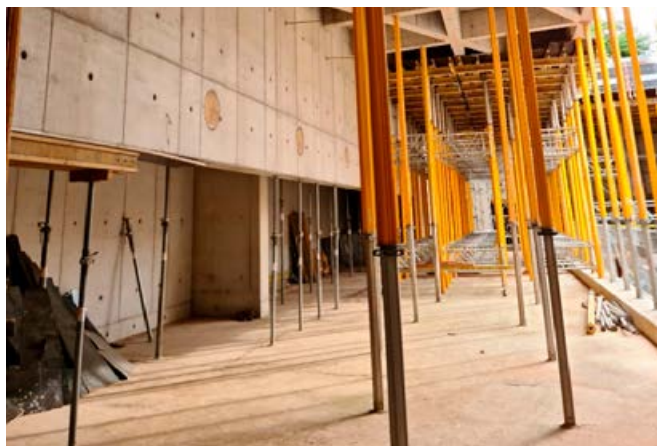
Fot. 13. Strop kasetonowy
