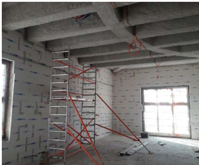
Fot. 20. Izolacja ścian wewnętrznych z perlitu ekspandowanego
