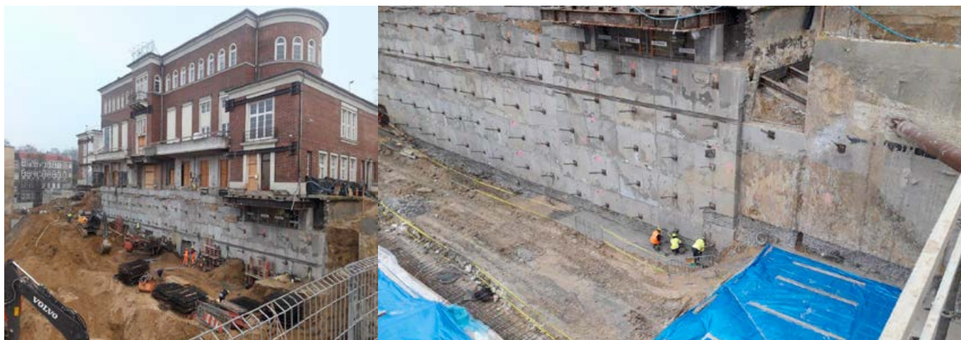
Fot. 10. Widok podbicia fundamentów zabytkowego budynku Teatru wraz ze ścianą dociskową
