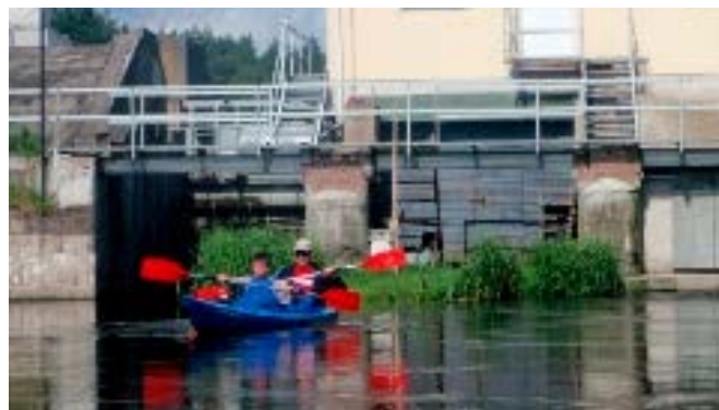
Rzeka Piława. Spływ do Nadarzyc. Elektrownia wodna (posadowiona na poniemieckim jazie fortecznym). Kajaki przenosiłmy lewym brzegiem ok. 60 m
