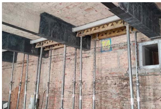
Fot. 18. Wzmocnianie podciągów na zginanie i ścinanie taśmami węglowymi
