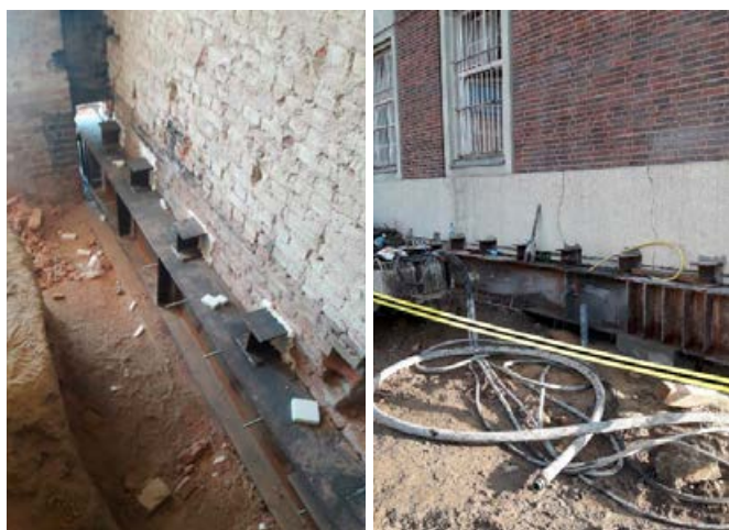
Fot. 15. Montaż belek BS1 i BS2
