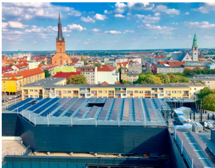
Panele PV na dachu budynku
