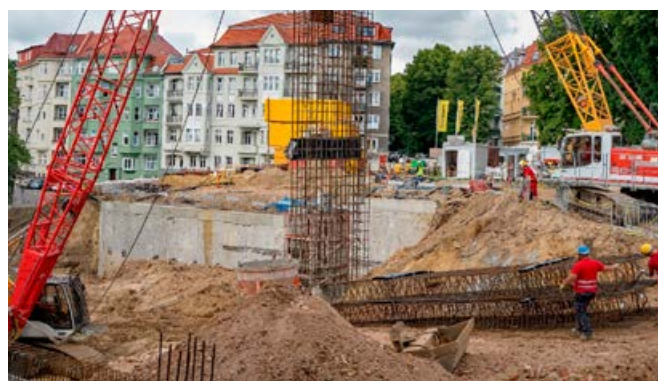
Fot. 5. Realizacja ściany szczelinowej DW1 od strony południowej
