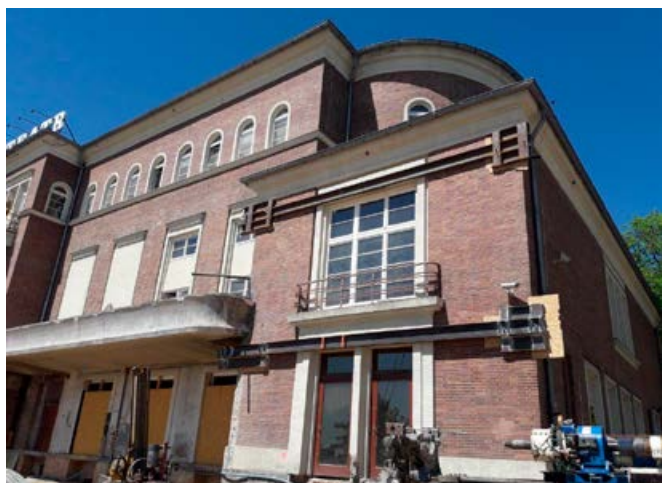
Fot. 14. Spięcie ryzalitów ściągnięciami SC1
