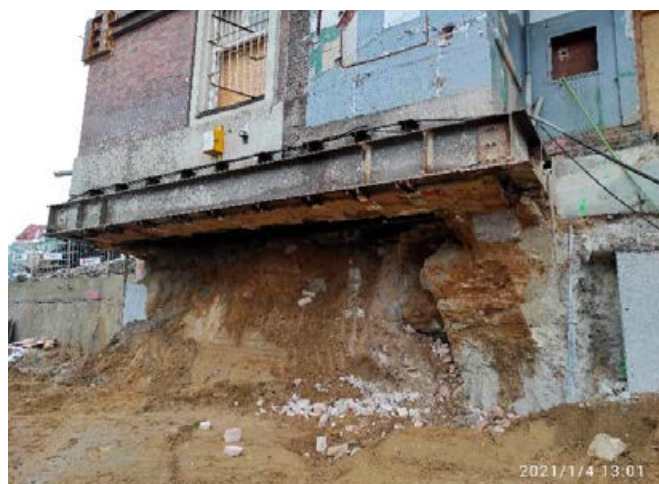
Fot. 17. Pełne podwieszenie ryzalitu i usunięcie gruntu
