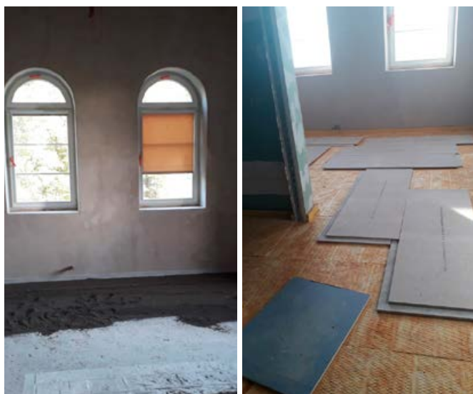
Fot. 21. Wykonywanie suchych jastrychów
