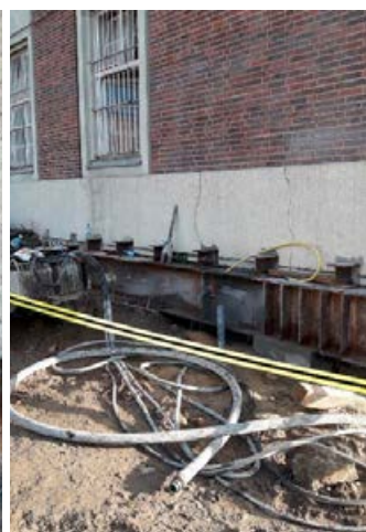
Fot. 16. Montaż belek B2
