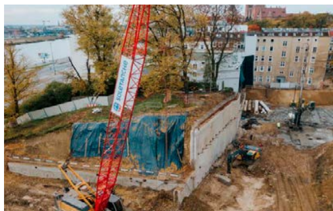
Fot. 4. Wykonywanie ściany szczelinowej DW3 od strony południowej o wysokości 23 m.b.
