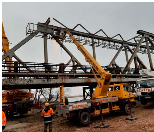
Fot. 26. Rozbiórka przęsła A z ładu
