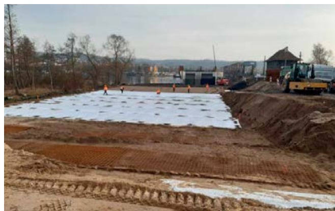
Fot. 16. Przygotowanie nasypu – platformy do wykonania montażu konstrukcji
