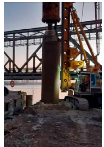
Fot. 6. Palownica podczas pracy na platformie roboczej podpory 3F
