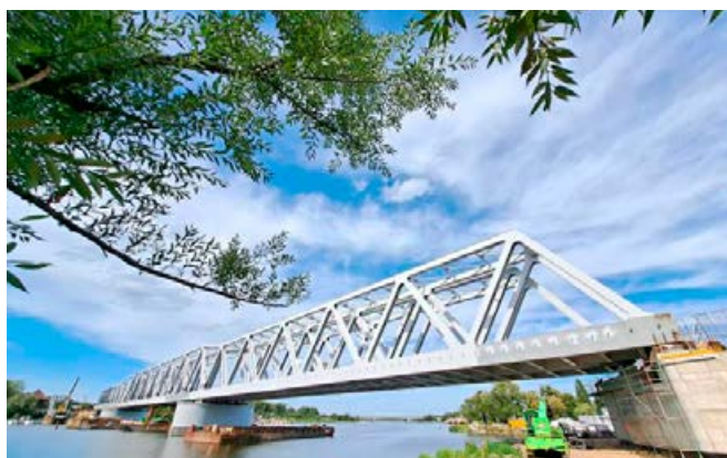
Fot. 23. Konstrukcja stalowa mostu po zakończeniu nasuwu (widok od podpory P1)
