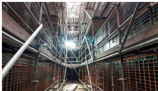
Fot. 12. Wykonywanie zbrojenia filara 2F odczepu z montażem rozpór narożnych na komorze
