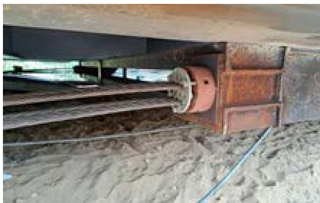
Fot. 20. Szczegół zakotwienia biernego i czynnego ciągów linowych do nasuwu konstrukcji
