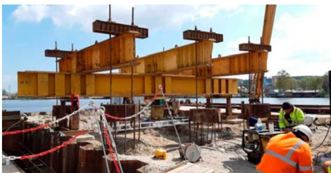
Fot. 8. Stanowisko do statycznego próbnego obciążenia pala na podporze 3F
