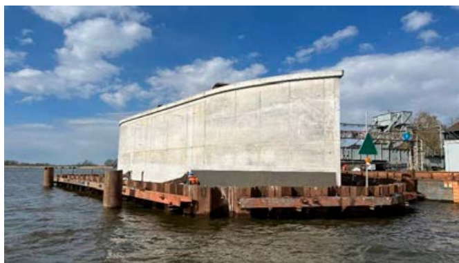
Fot. 15. Wykonanie izolacji z zaprawy cementowo-epoksydowej na podporze 3F
