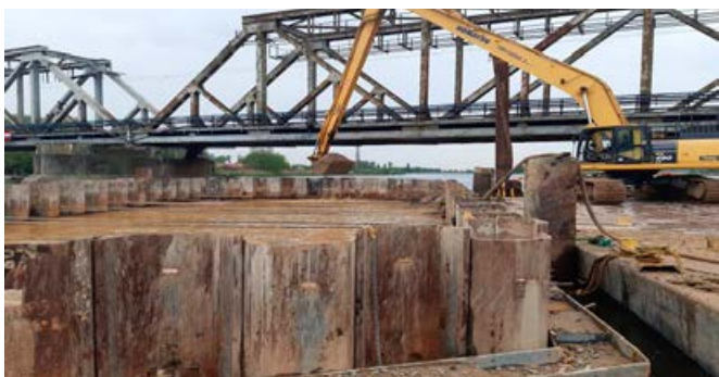
Fot. 9. Usunięcie zasypu piaskowego z komór koparek typu Long ustawionymi na jednostkach pływających do rzędnej -10,0 m spodu korka betonowego
