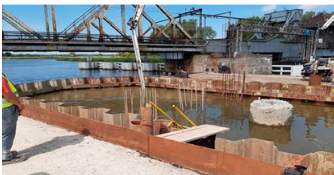
Fot. 10. Podwodne betonowanie korka betonowego grubości 2,5 m, jako uszczelnienie dna komory z betonu C20/25 o łącznej objętości 1400 m 3
