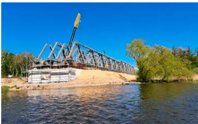
Fot. 17. Montaż konstrukcji stalowej na leżni za przyczółkiem P4
