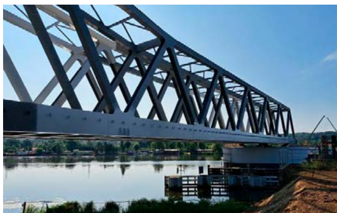
Fot. 22. Konstrukcje stalowe po wykonaniu I taktu nasuwu (widok od podpory P4)
