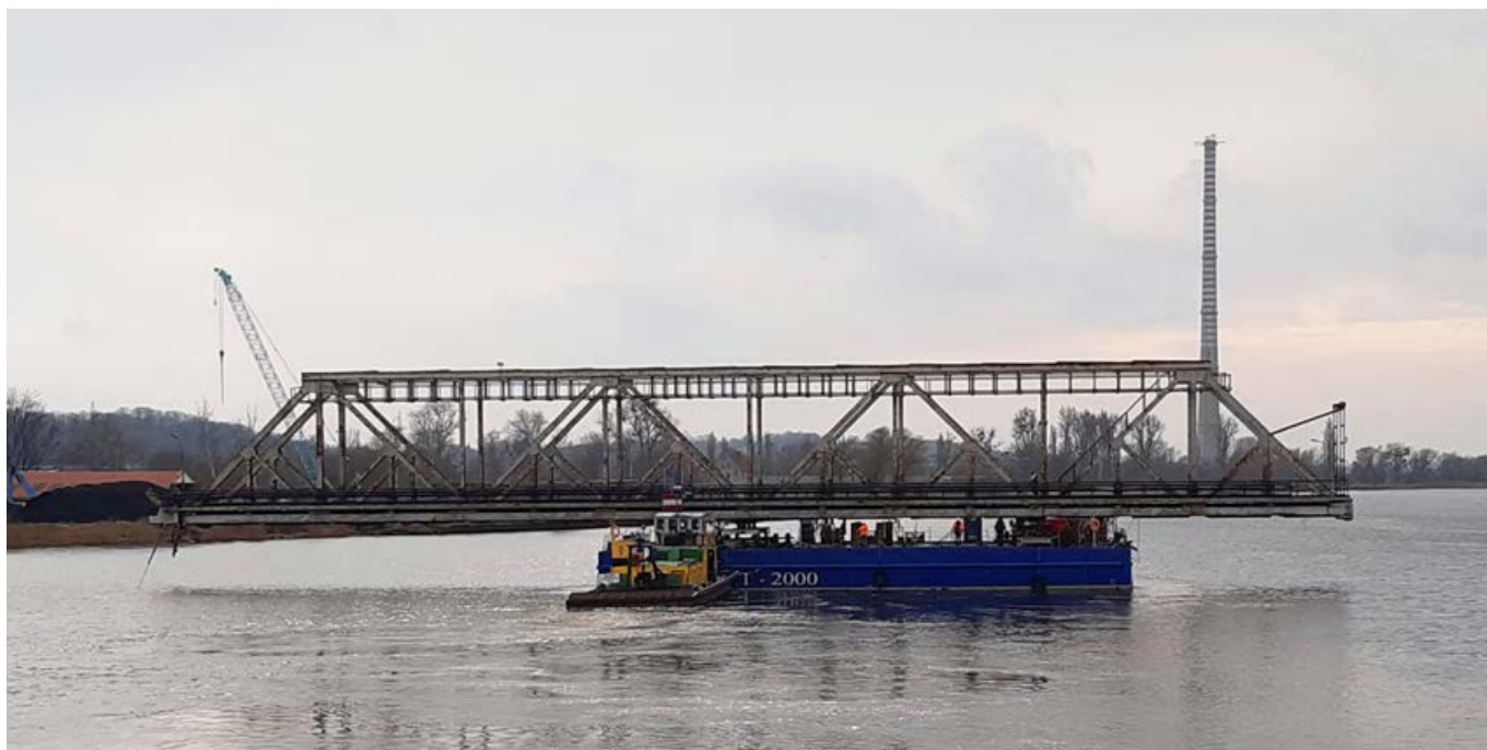
Fot. 27. Transport pontonem przęsła C na miejsce rozbiórki (podparcie niesymetryczne)
