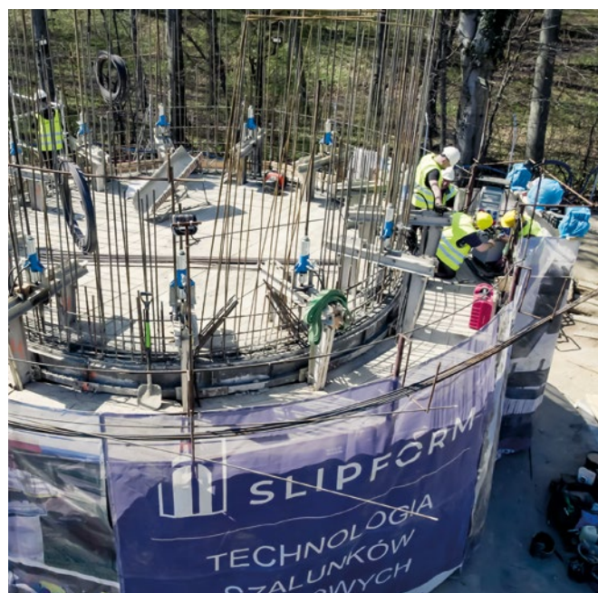
Fot. 1. Przykładowy szalunek ślizgowy, przygotowany na potrzeby budowy wieży radarowej
