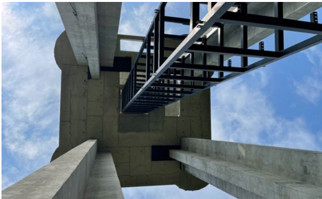
Fot. 2. Budowa wieży widokowej w Słubicach: Wysokość 30 m, przekrój 12 x 12 m, czas wznoszenia słupów 14 dni
