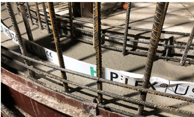
Fot. 6. Układanie mieszanki betonowej w szalunku. Zastosowanie taśmy „PENTAFLEX” w przerwie technologicznej
