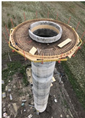
Fot. 4. Budowa wieży radarowej dla PAŻP: Wysokość 35 m, średnica 5,90 m, czas realizacji 10 dni
