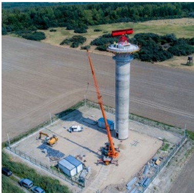
Fot. 4. Budowa wieży radarowej dla PAŻP: Wysokość 35 m, średnica 5,90 m, czas realizacji 10 dni
