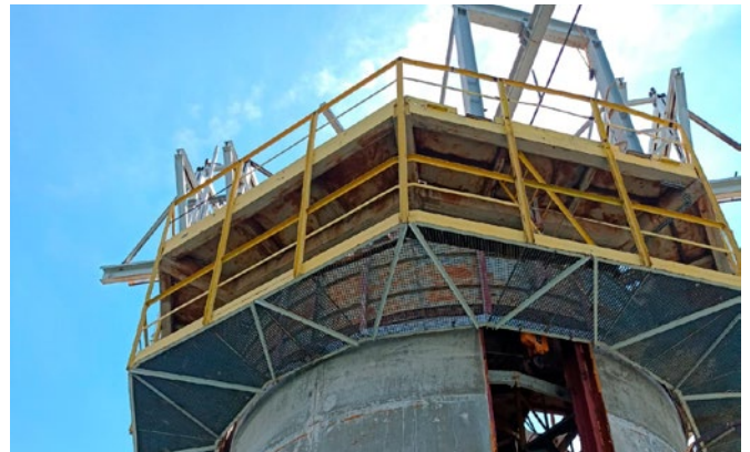
Fot. 3. Nadbudowa wieży ujęciowej KGHM – Rudna: Wysokość 4,30 m, przekrój 6 m, czas realizacji 21 dni
