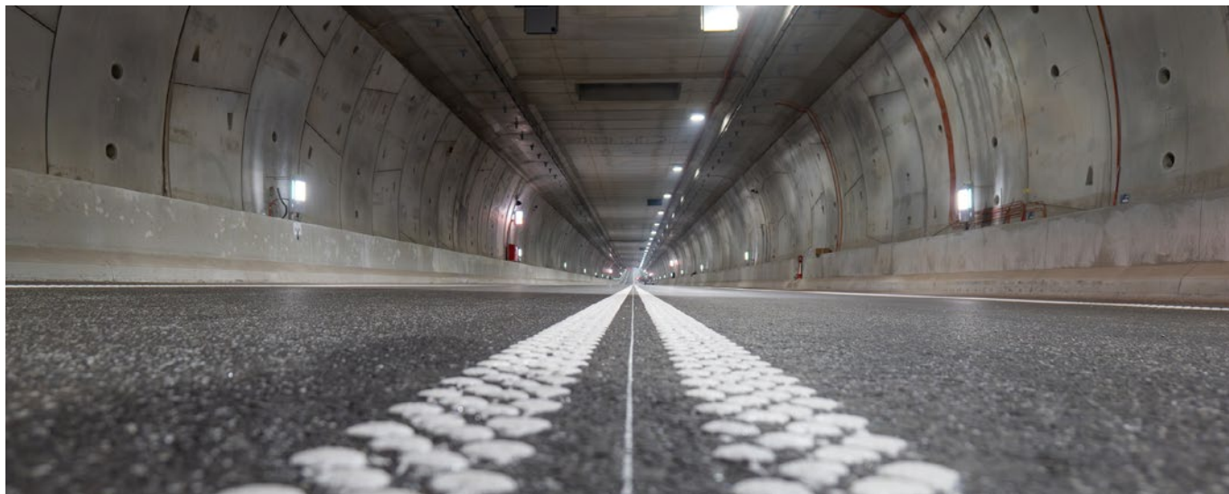
Fot. 1. Średnio dziennie przez tunel w Świnoujściu w obie strony przejeżdża od 15 do 16 tys. pojazdów
