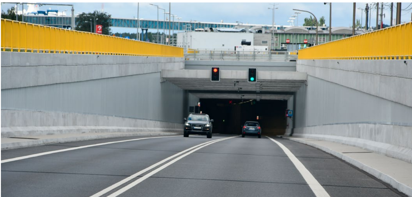
Fot. 4. Wjazd/wyjazd z tunelu po stronie wyspy Wolin znajduje się przy ulicy Fińskiej, w pobliżu Terminala Promów Morskich
