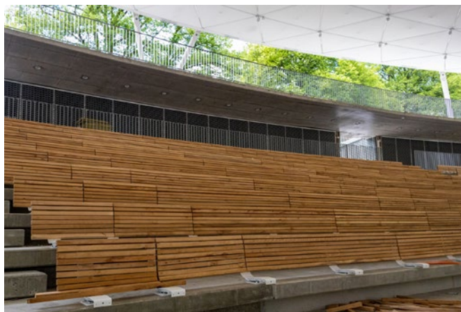
Fot. 5. Widok na widownię
