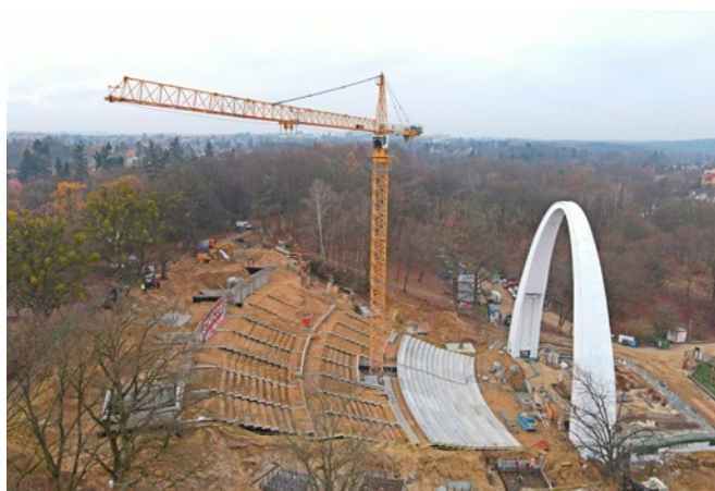
Fot. 2. Stan robót na 14 grudnia 2020 r.
