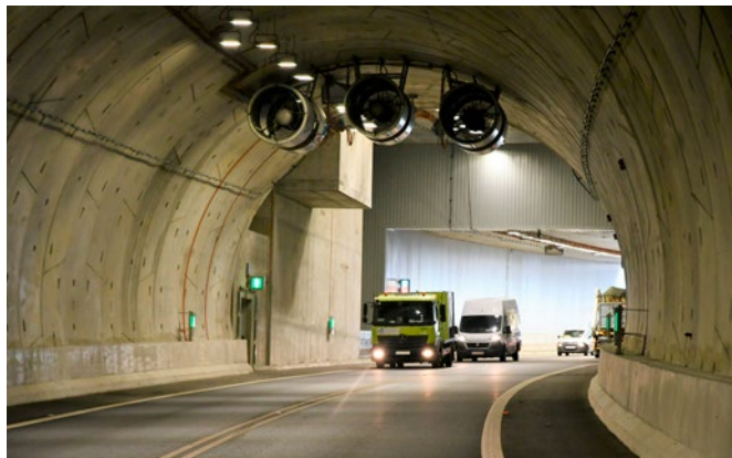
Fot. 3. Tunel otwarty dla ruchu samochodowego
