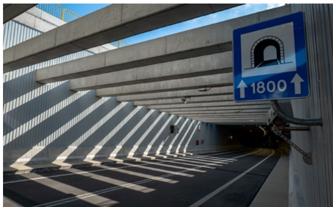
Fot. 2. Wjazd do tunelu pod Świną
