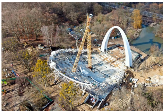
Fot. 3. Stan robót na 17 marca 2021 r.
