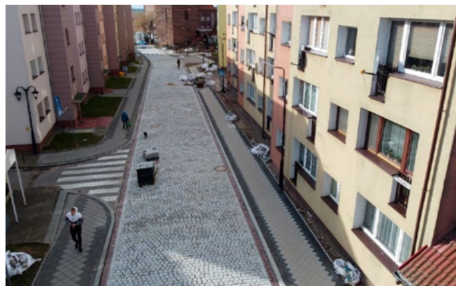
Ulica Basztowa po wykonanej przebudowie
