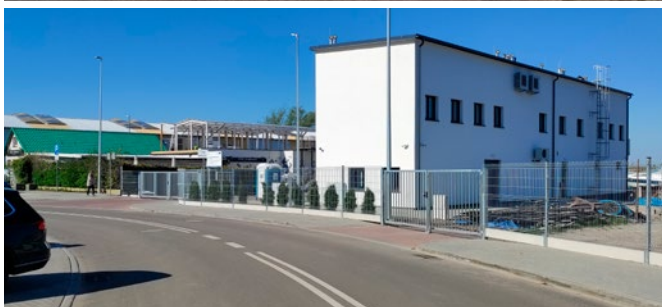
Nowy budynek obsługi portu wraz z przebudowaną drogą dojazdową (fotografia u góry przedstawia port przed modernizacją)
