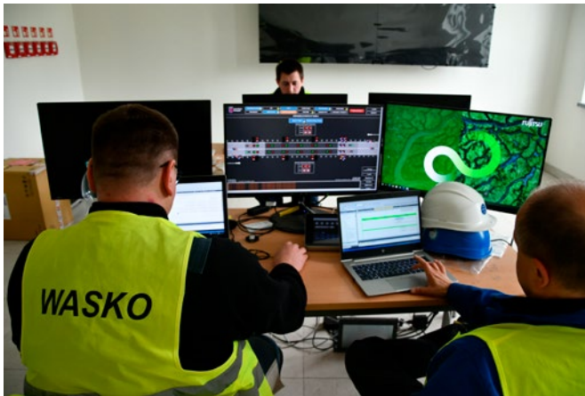
Na zdjęciu montaż systemów kontroli tunelu w budynku Biura Centrum Obsługi, które znajduje się przy wjeździe/wyjeździe z tunelu na wyspie Uznam
