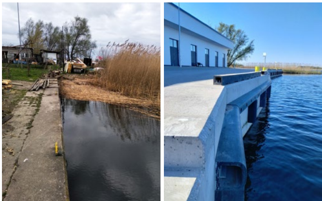
Nowo wybudowane nabrzeże przy budynku rybackim (przed i po)
