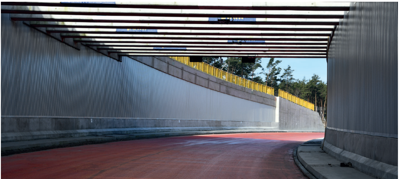
Wjazd/wyjazd z tunelu po stronie wyspy Uznam
