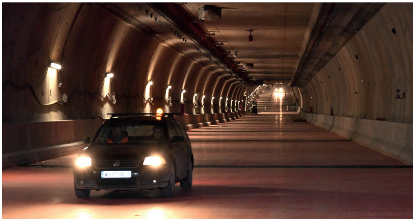
Wnętrze tunelu. W tle najgłębszego jego miejsca, czyli 39 m poniżej lustra cieśniny Świny
