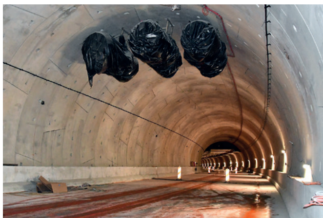
Wjazd do tunelu od strony wyspy Wolin. U góry widać (jeszcze osłonięte folią) wentylatory
