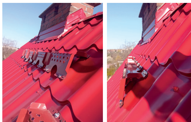
Atestowane ławy kominiarskie – atestowane tylko do komunikacji pionowej!
