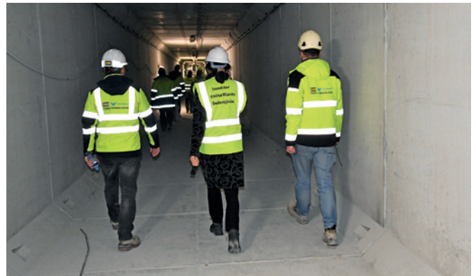
Droga ewakuacyjna biegnąca pod jezdnią. Na zdjęciu idą (od lewej) dyrektor kontraktu Piotr Flisiak, przedstawiciel inwestora i Zastępca Prezydenta Świnoujścia Barbara Michalska i kierownik budowy Sławomir Skraba
