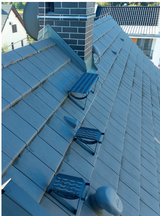
Stopnie do komunikacji pionowej wykorzystane jako komunikacja pozioma
