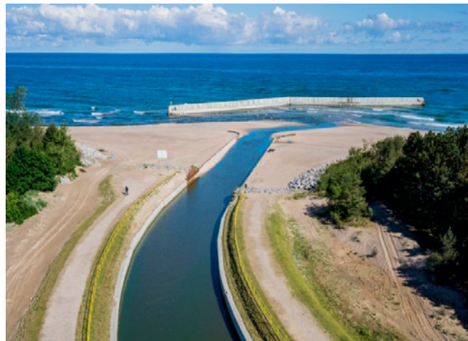
Po wykonaniu konstrukcji ochrony brzegu morskiego
