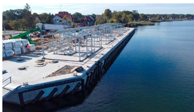
Nowo budowana przystań rybacka wraz z zapleczem dla rybaków
