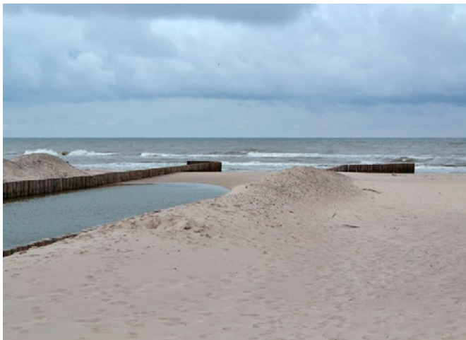
Przed wykonaniem konstrukcji ochrony brzegu morskiego
