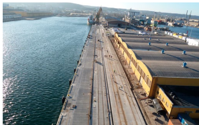
Nabrzeże Rumuńskie – po wykonaniu przebudowy
