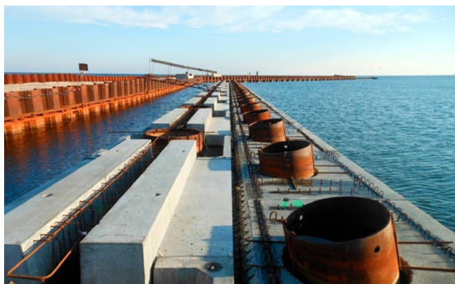
Konstrukcja wsporcza falochronu
