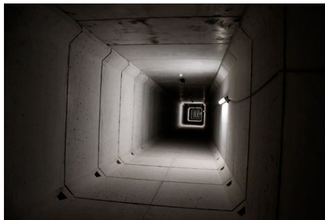
Droga ewakuacyjna z tunelu
