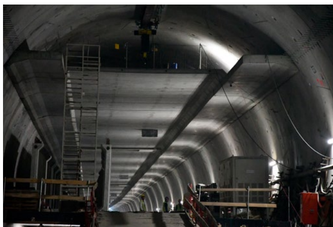
Budowa konstrukcji sufitowej
