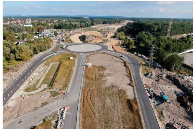
Dojazd do tunelu po stronie wyspy Wolin. Nowe rondo – środkowa ulica prowadzi do tunelu, dwie pozostałe do terminalu promowego i ul. Fińskiej
