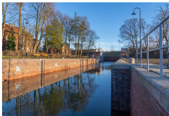
Zabytkowa Śluza Północna po wykonanej rewitalizacji
