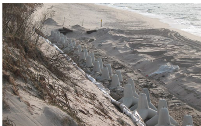
Opaska brzegowa – etap przed wykonaniem narzutu kamiennego
