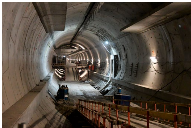
Budowa jednego z wyjść ewakuacyjnych
