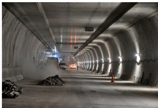
Wnętrze tunelu z przygotowanym stropem pod sufit i częścią jezdnią
