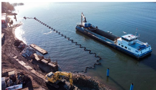
Wykonane posadowienie nabrzeża – ścianka szczelna wspornikowa o profilu GU-13N + zamki Omega 18 i trwające prace czerpalne
