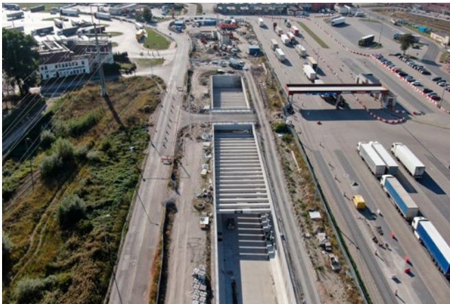
Wjazd-wyjazd z tunelu na wyspie Wolin, część wykonana metodą stropową
