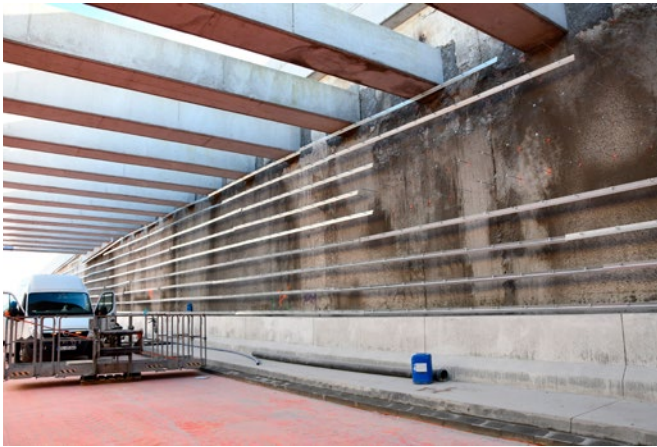
Przygotowanie podłoża do montażu ekranów dźwiękochłonnych po stronie wyspy Wolin
