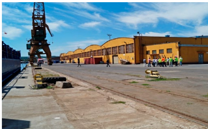
Nabrzeże Rumuńskie – wykonanie układu kolejowego – przed rozpoczęciem prac
