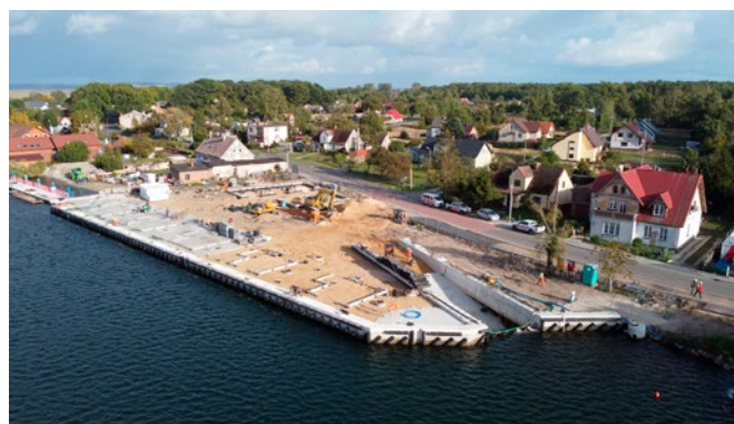
Modernizacja przystani rybackiej w Karsiborze celem poprawy bezpieczeństwa rybaków
