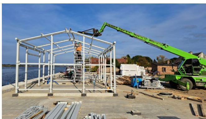
Montaż konstrukcji stalowej magazynów wyładowniczych
