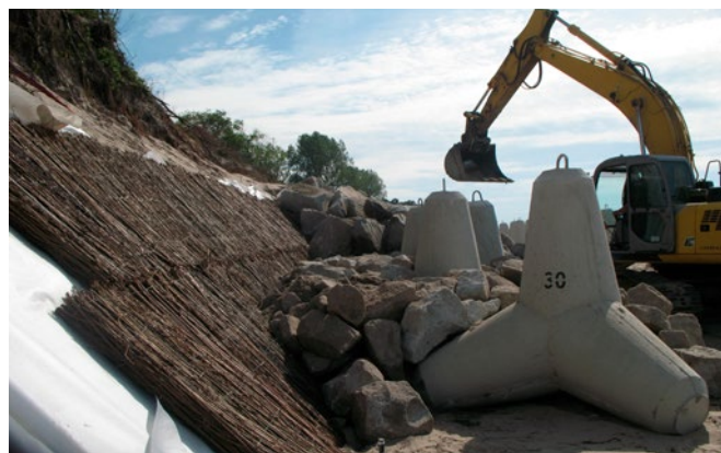
Wykonanie opaski brzegowej – montaż materacy faszynowych i gwiazdobloków
