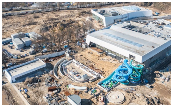
Montaż zewnętrznych niecek basenowych (marzec 2022 r.)
