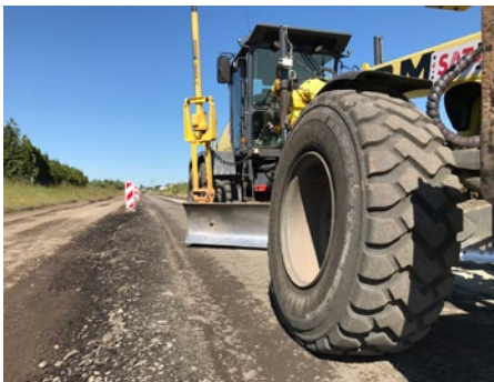
Wykonanie warstwy MCE
