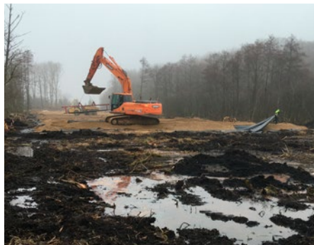
Platforma robocza pod pale przemieszczeniowe
