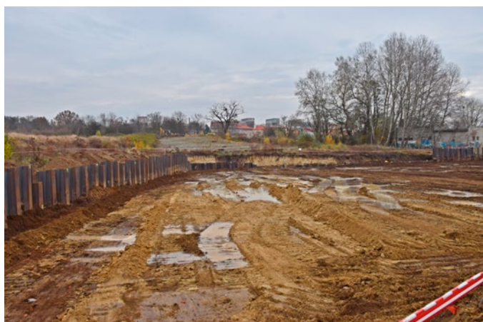
Roboty ziemne, montaż ścianek szczelnych (listopad 2019 r.)
