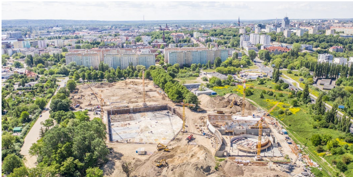
Montaż ścian Edukatorium (czerwiec 2020 r.)
