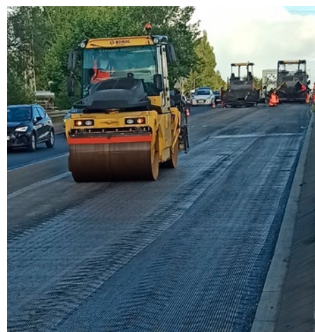
Układanie siatki wzmacniającej
