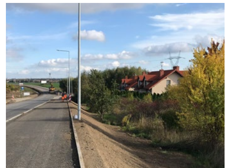
Plantowanie i humusowanie skarp
