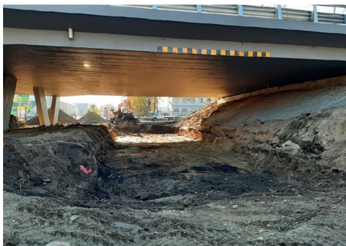
Wykonywanie prac ziemnych
