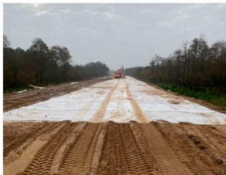
Układanie geotkaniny pod materac na palach
