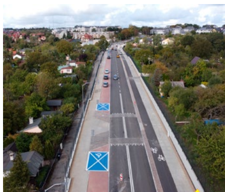
ul. Hoża po modernizacji
