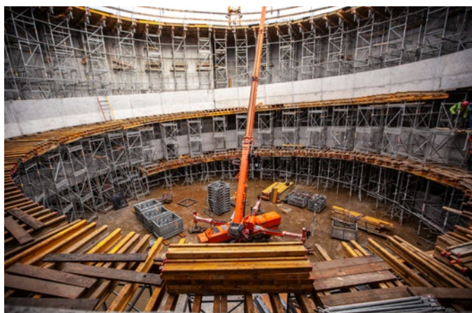
Wykonywanie konstrukcji wiru wiedzy (listopad 2020 r.)
