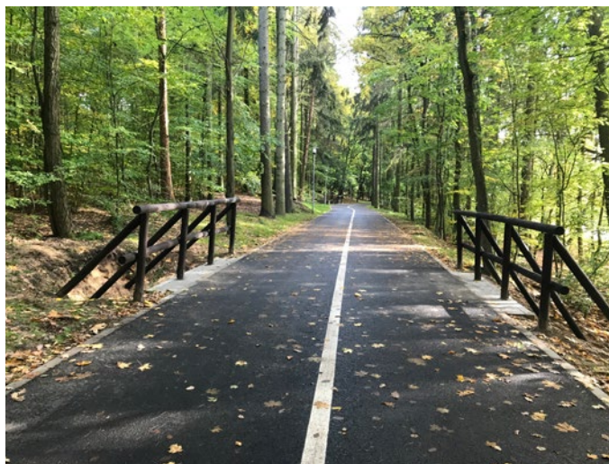
Ścieżka rowerowa wraz z przepustem dla małych zwierząt
