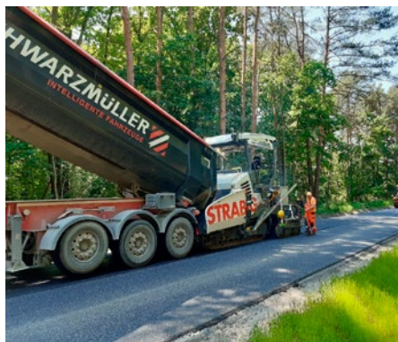
Układanie warstwy wiążącej na ul. Kupczyka
