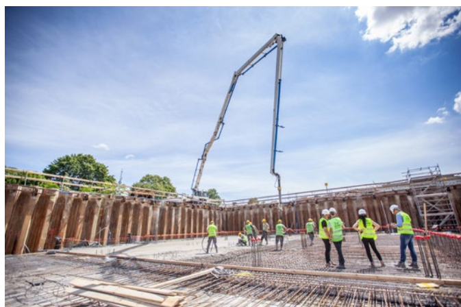
Wykonywanie płyty fundamentowej budynku aquaparkowego (czerwiec 2020 r.)
