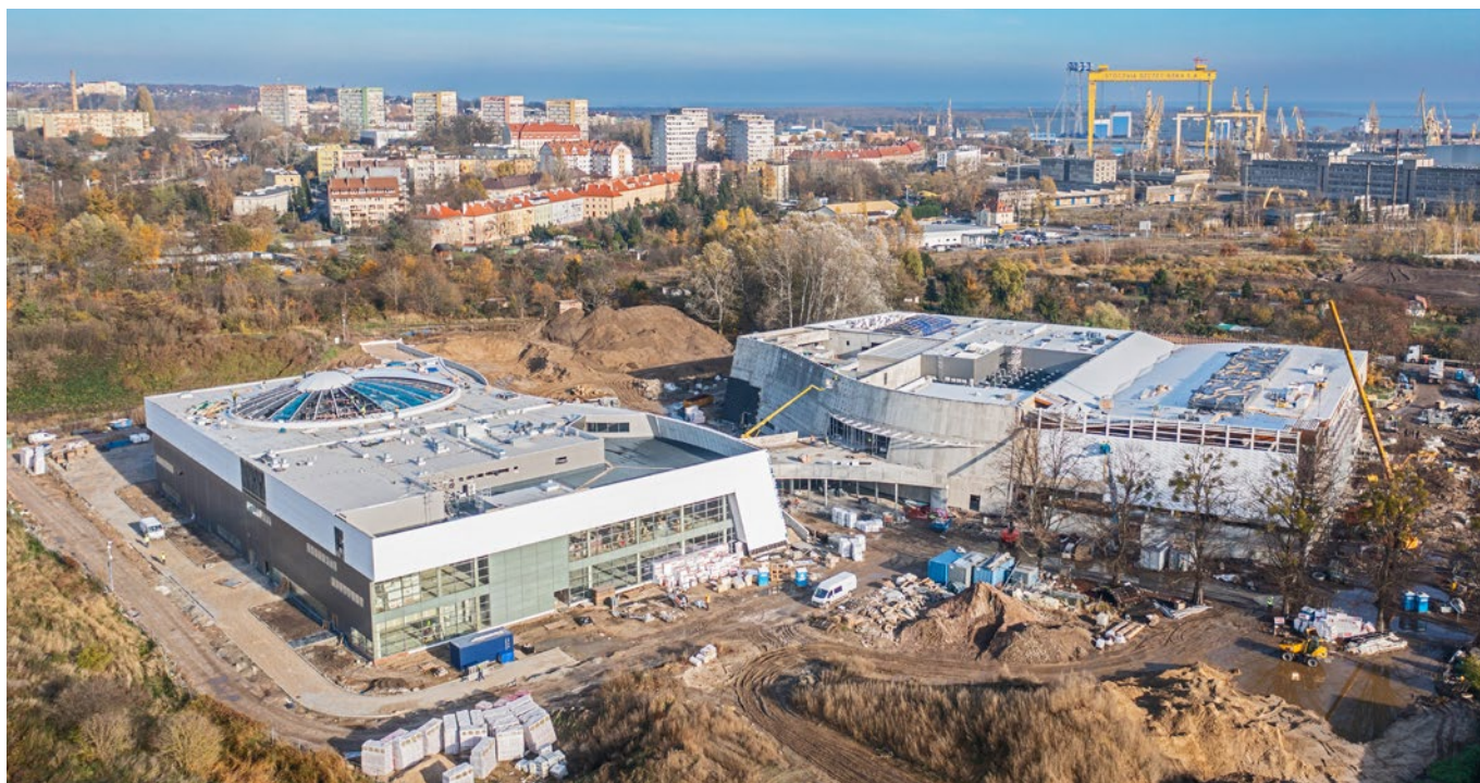
Prace konstrukcyjne (listopad 2021 r.)
