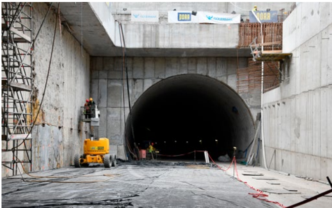
Komora odbiorcza i wjazd do tunelu wykonanego metodą TBM (wyspa Wolin)
