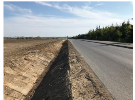
Wykonanie rowu odwadniającego
