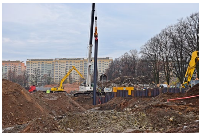
Roboty ziemne, montaż ścianek szczelnych (listopad 2019 r.)
