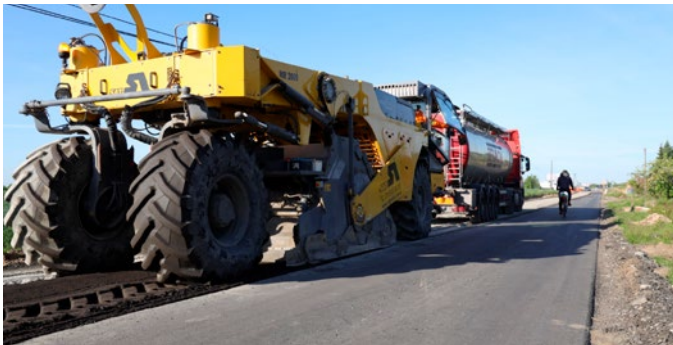
Wykonanie warstwy MCE
