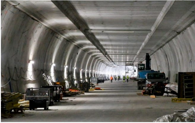
Tuż przed wylotem z tunelu po stronie wyspy Wolin. Widoczna płyta poddrogowa
