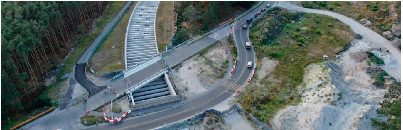
Wyspa Uznam i początek tunelu wykonany metodą stropową
