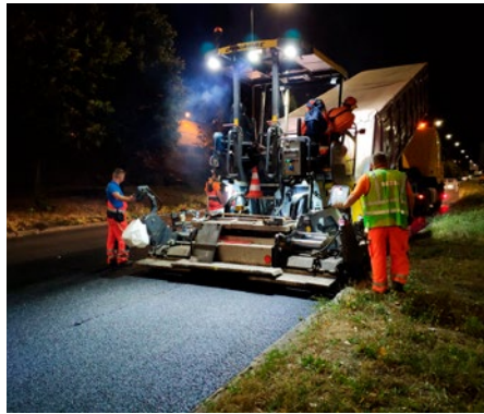
Układanie mieszanki mineralno-asfaltowej w nocy
