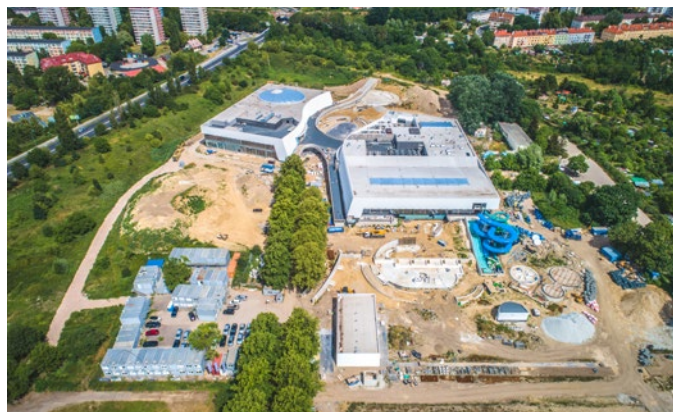
Wykonywanie zagospodarowania terenu (lipiec 2022 r.)
