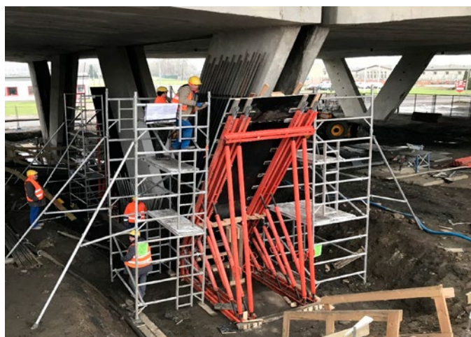
Zbrojenie i deskowanie filara
