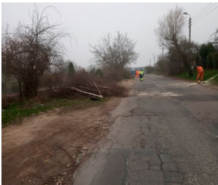
Ulica Hoża przed rozpoczęciem prac
