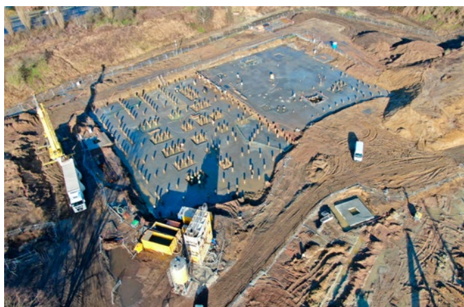
Płyta fundamentowa budynku Edukatorium (luty 2020 r.)
