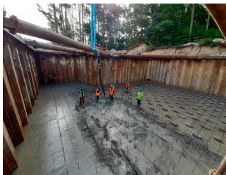
Betonowanie płyty korka żelbetowego pod projektowaną konstrukcją zbiornika
