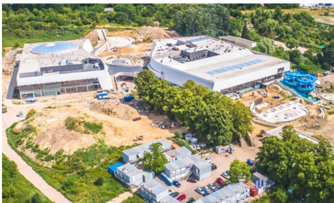
Prace wykończeniowe, w tle widoczna kaskada wodna (lipiec 2022 r.)
