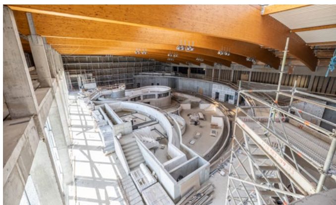
Prace wykończeniowe na hali basenowej (marzec 2022 r.)
