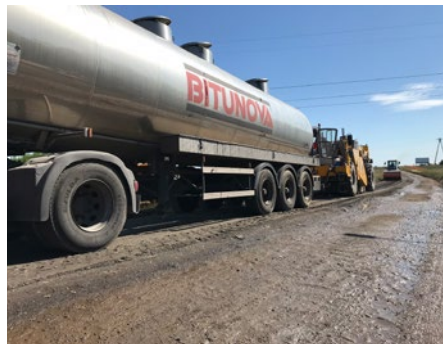
Wykonanie warstwy MCE
