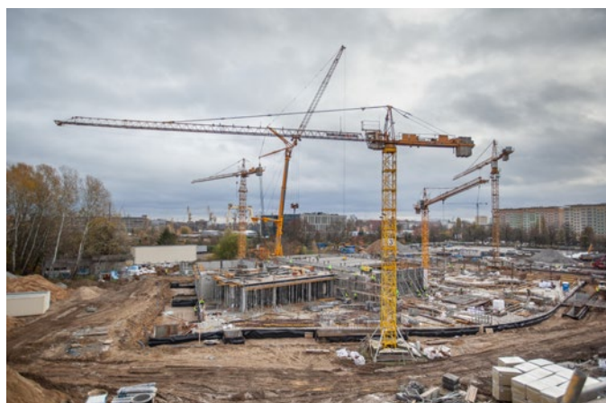
Betonowa konstrukcja parteru budynku basenowego (listopad 2020 r.)
