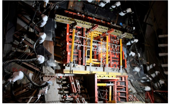
Budowa wyjścia ewakuacyjnego metodą mrożenia gruntu
