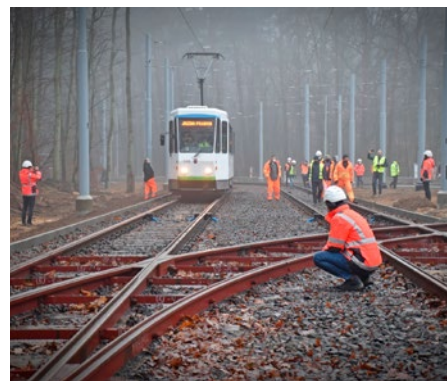
Przejazd techniczny na odcinku Pętli Głębokiej
