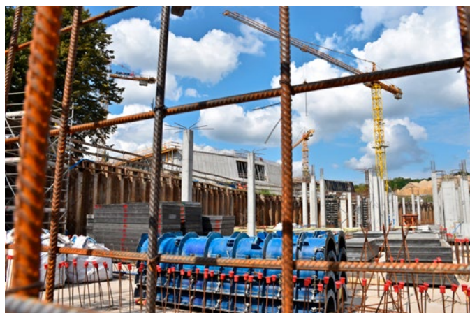
Zbrojenie, wykonywanie ścian oraz słupów w podbaseniu (sierpień 2020 r.)
