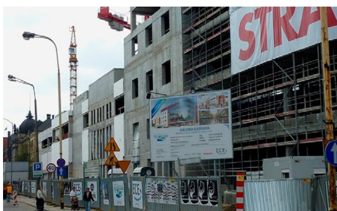
Galeria Kaskada, lata budowy: 2008–2011
