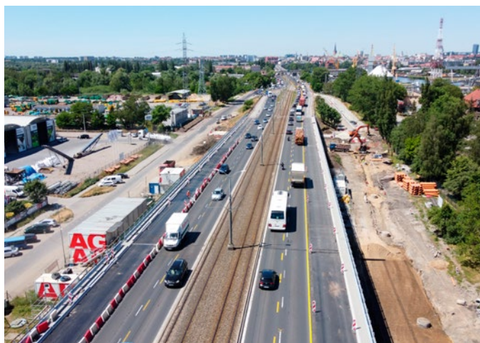
Estakada Pomorska – widok na ul. Gdańską
