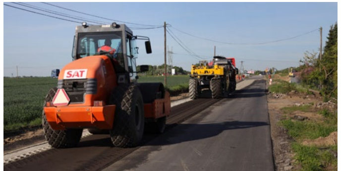
Wykonanie warstwy MCE
