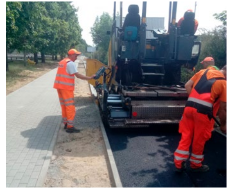
Budowa ścieżki rowerowej
