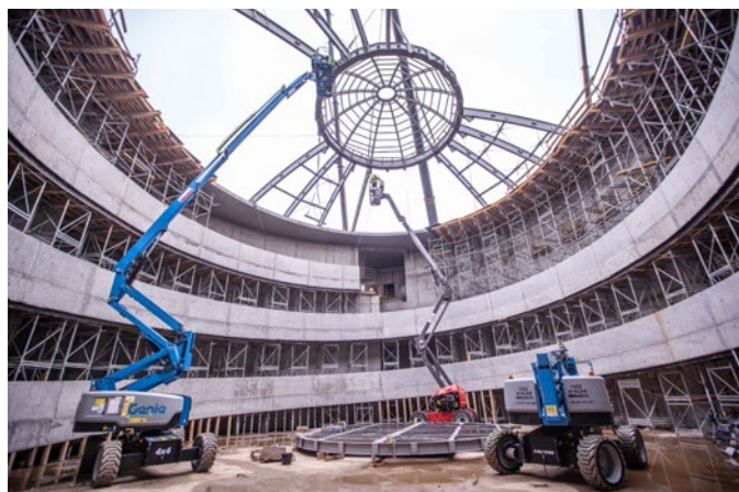
Montaż stalowej konstrukcji świetlika (grudzień 2020 r.)
