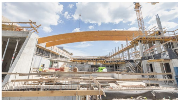
Montaż konstrukcji drewnianej zadaszania nad halą basenową (lipiec 2021 r.)
