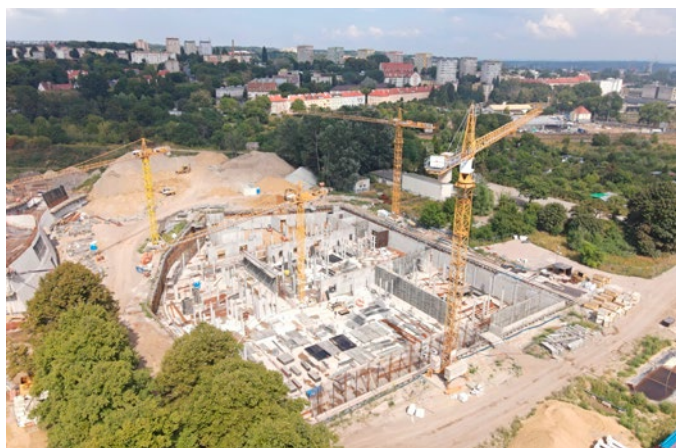
Zbrojenie, wykonywanie ścian oraz słupów w podbaseniu (sierpień 2020 r.)
