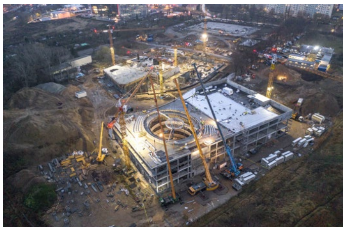
Montaż stalowej konstrukcji świetlika (grudzień 2020 r.)
