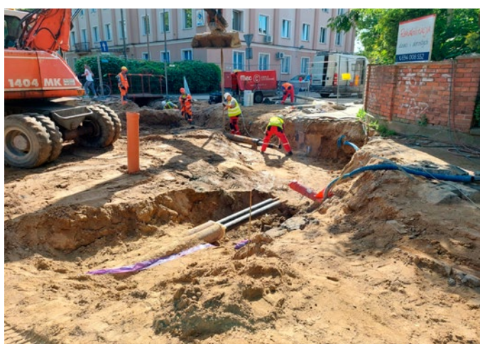
Likwidacja kolizji z istniejącym ciepłociągami
