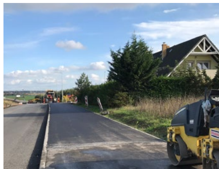
Wykonanie warstw bitumicznych na ciągu pieszo-rowerowym
