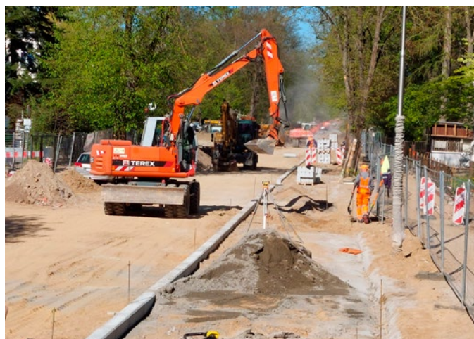
Budowa ścieżki rowerowej i chodników
