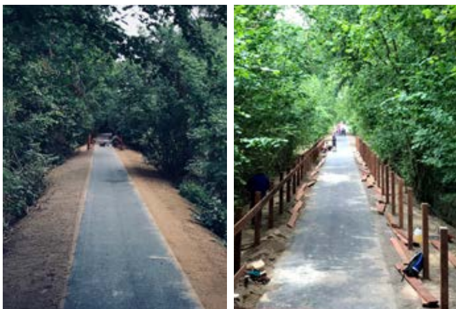
Fot. 8, 9. Przebieg ścieżki przez nasyp po nieczynnej linii kolejowej wąskotorowej. Uciążliwość wykonawstwa z uwagi na brak dostępu do terenu podczas wykonywania prac. Trasa rowerowa Pomorza Zachodniego – Trasa Blue Velo, odcinek Gryfino–Trzcińsko Zdrój
