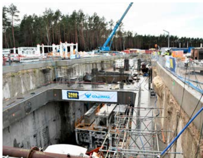
Fot. 12. Komora startowa
