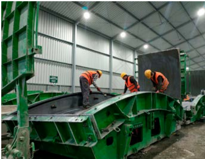
Fot. 5. Produkcja zakładu prefabrykacji
