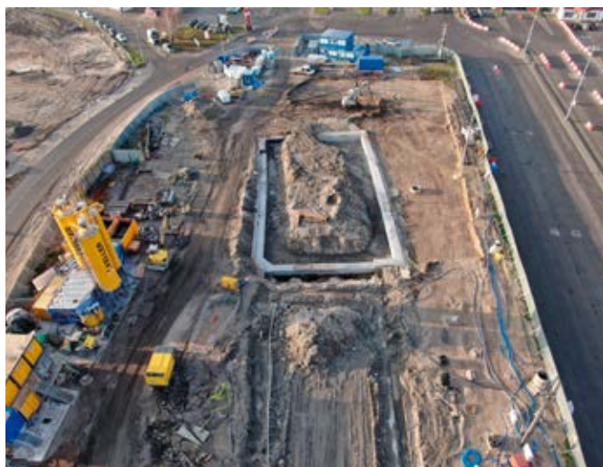
Fot. 11. Budowa komory odbiorczej
