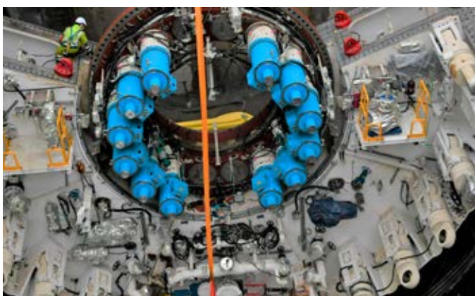
Fot. 7–10. Głowica urabiająca tuż przed montażem w komorze startowej i montaż maszyny TBM w komorze startowej
