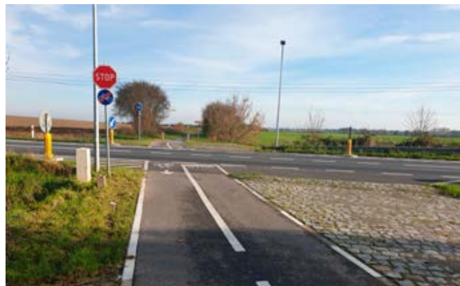
Fot. 6. Przecięcie ścieżki rowerowej z drogą wojewódzką nr 120
