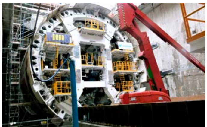
Fot. 7–10. Głowica urabiająca tuż przed montażem w komorze startowej i montaż maszyny TBM w komorze startowej
