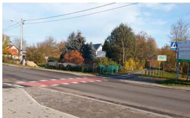
Fot. 7. Przecięcie ścieżki rowerowej z drogą powiatową w m. Stare Czarnowo
