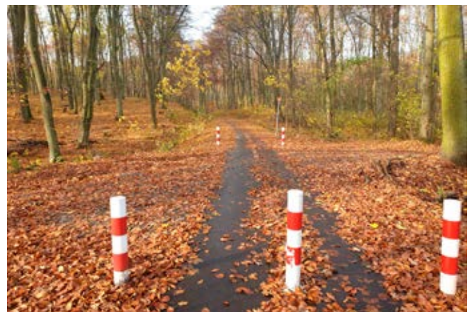
Fot. 10. Przykład montażu słupka zabezpieczającego i ograniczającego wjazd niepożądanym uczestnikom ruchu na ścieżkę rowerową
